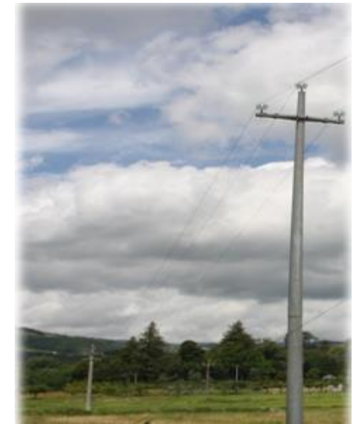
Linea di distribuzione a media tensione
