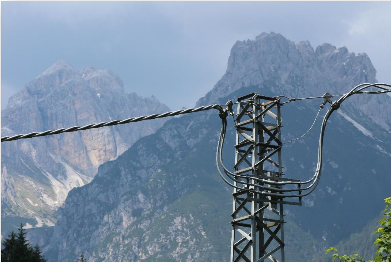
Linea a media tensione in cavo aereo
