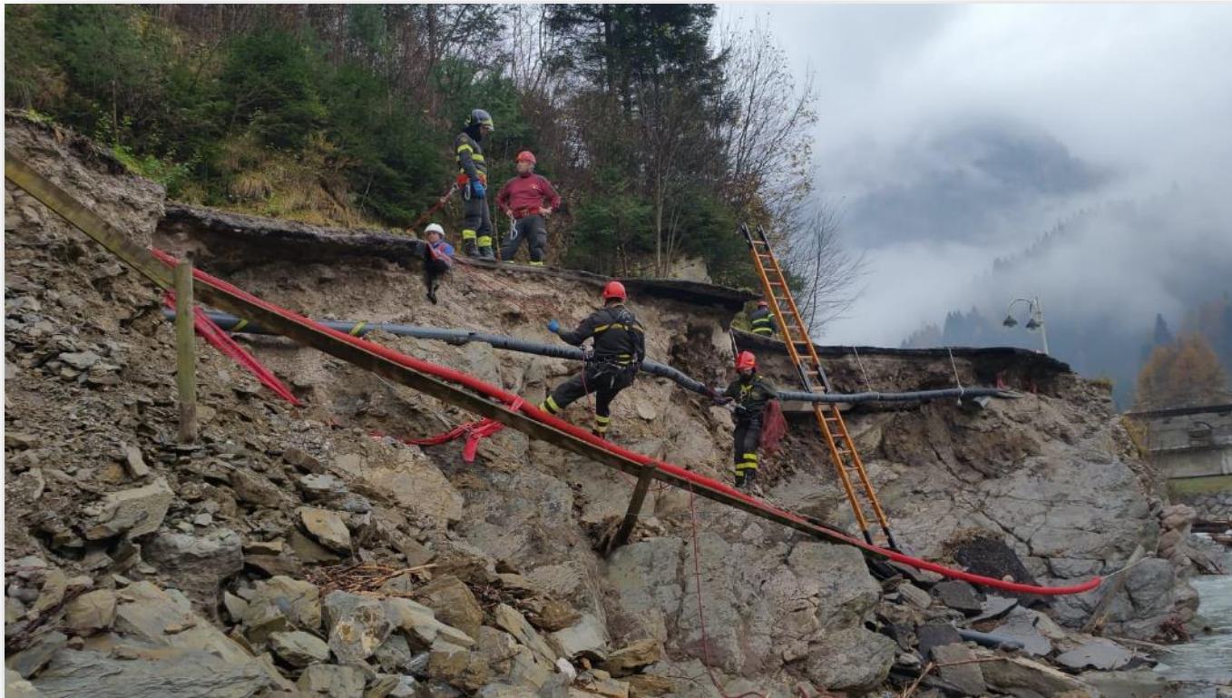
Un cavo interrato a media tensione riportato si strada dopo tempesta VAIA BL
