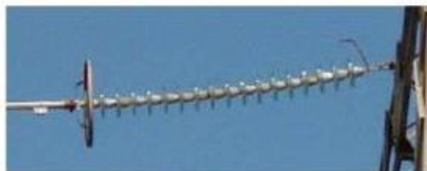
Linea a 220 kV
