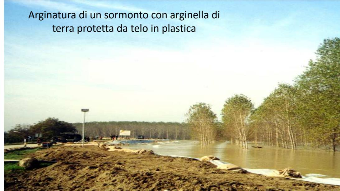
Arginatura di un sormonto con arginella di terra protetta da telo in plastica
