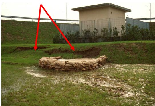
Cedimento dell'argine per sfiancamento dovuto alle infiltrazioni d'acqua e all'inzuppamento
