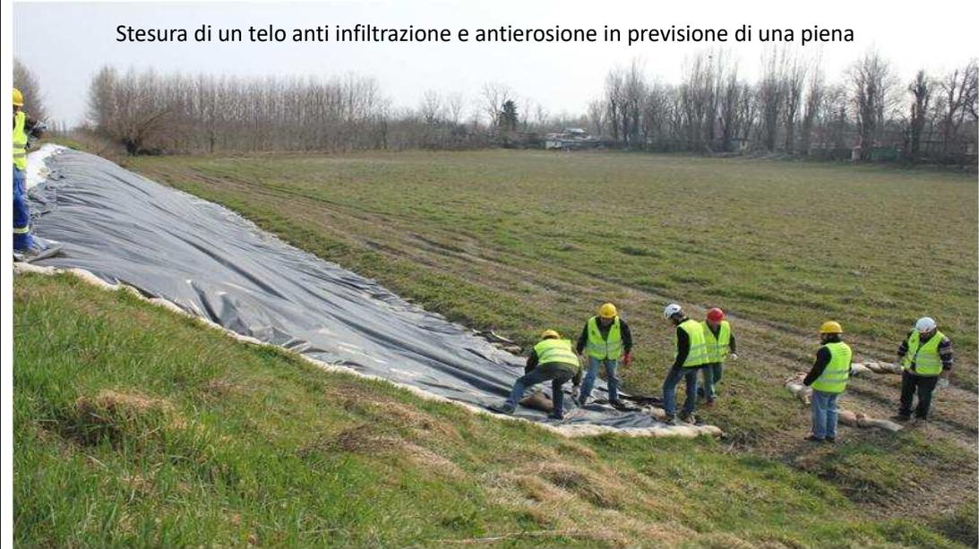
Stesura di un telo anti infiltrazione e antierosione in previsione di una piena
