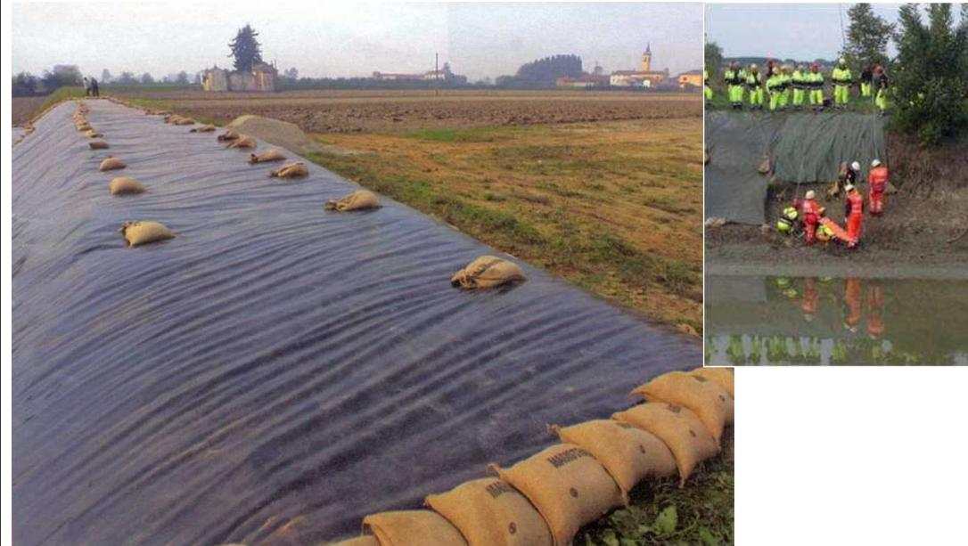
La tenuta dell'acqua della piena è garantita dalla bassa permeabilità dei componenti utilizzati per la costruzione
