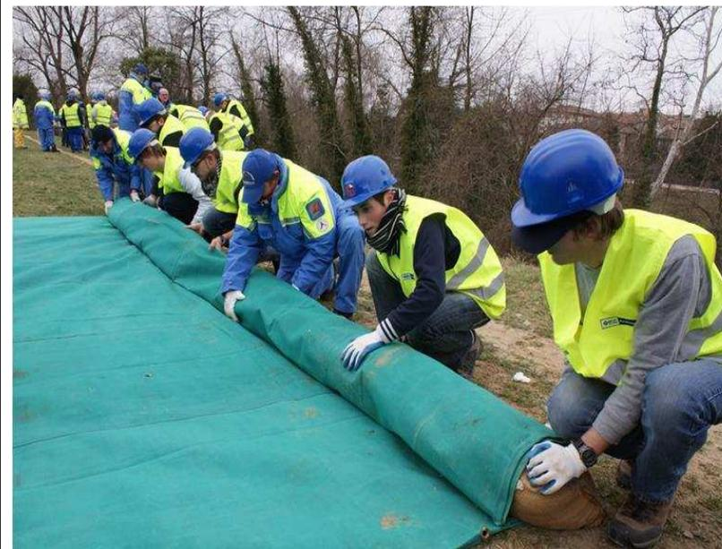
Preparazione di un telo anti infiltrazione con piena in corso
