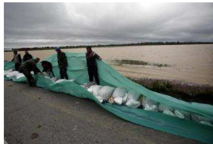
Per rendere impermeabile l'arginatura di un sormonto con i sacchi si può utilizzare un telo impermeabile disposto come in figura. Questo permette di approntare un'arginatura frettolosa ma sufficientemente efficace.
