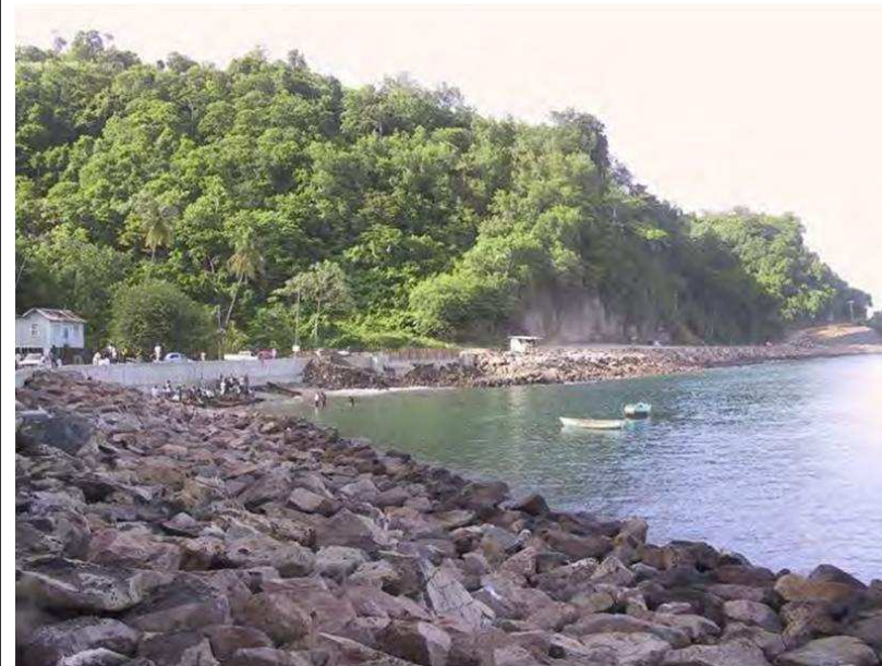
La distruzione della barriera corallina ha causato una forte erosione della costa
