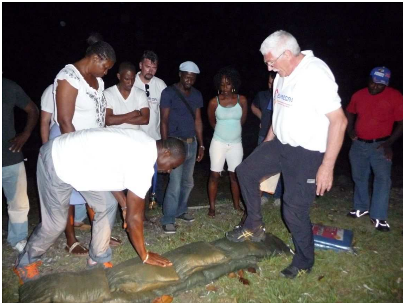
Dimostrazione per il corretto posizionamento dei sacchi di sabbia per ridurre al minimo l'infiltrazione di acqua.
