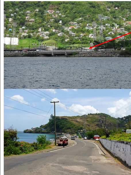
Estuario del fiume presso St. George in Grenada. Costeggia a nord la città e lo stadio di Cricket. La luce sotto il ponte che dovrebbe permettere il passaggio dell'onda di piena è troppo stretta
