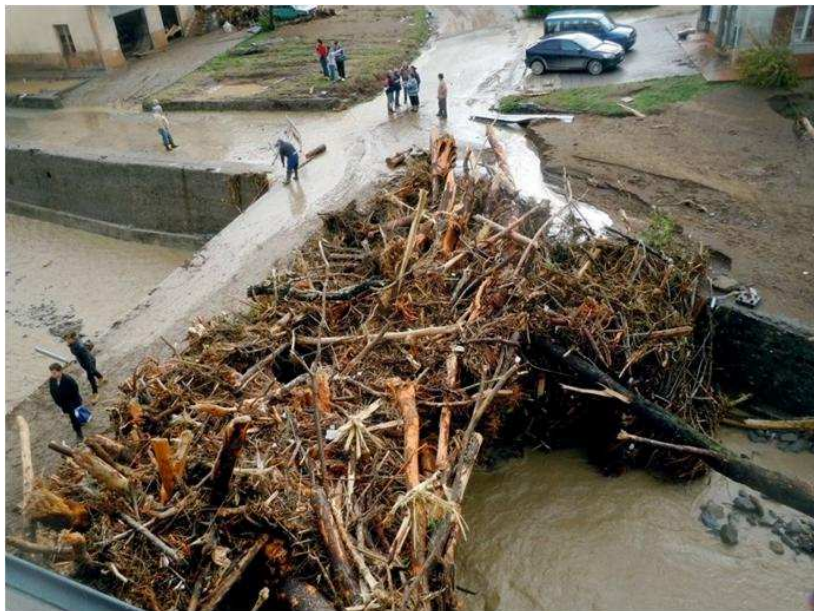
Alberi sradicati e ramaglie accumulate sotto un ponte. Alluvione di Alessandria 1994
