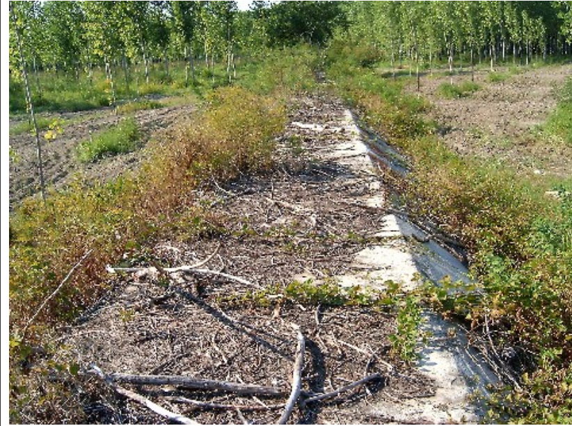
Esempio di pennello a sormonto
