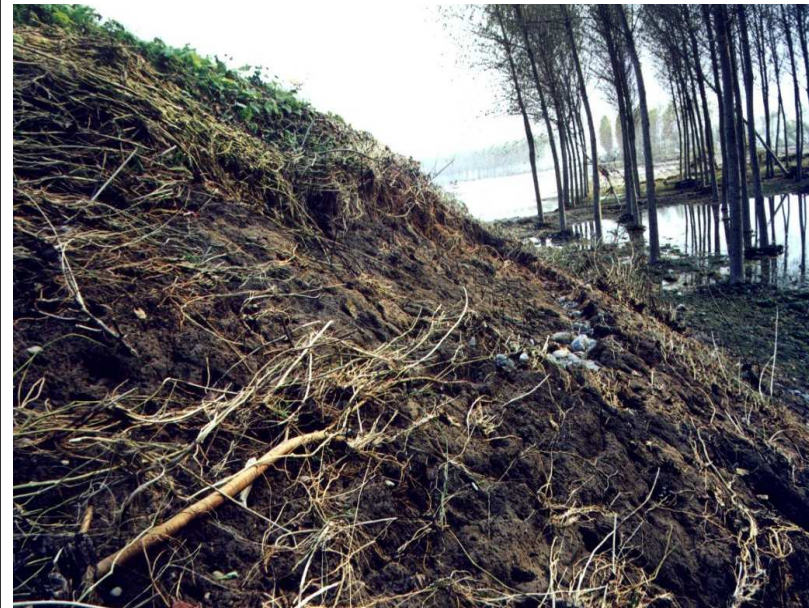
Alluvione ottobre 2000 - Erosione argine in località Regona (Santo Stefano Lodigiano)
