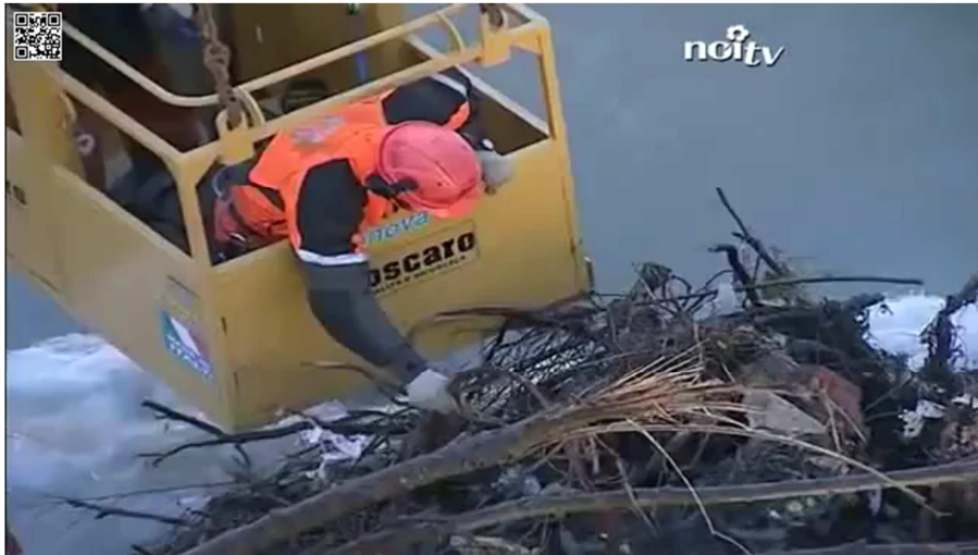
Fiume Serchio – Rimozione di tronchi e rami dalle pile del ponte del Diavolo
