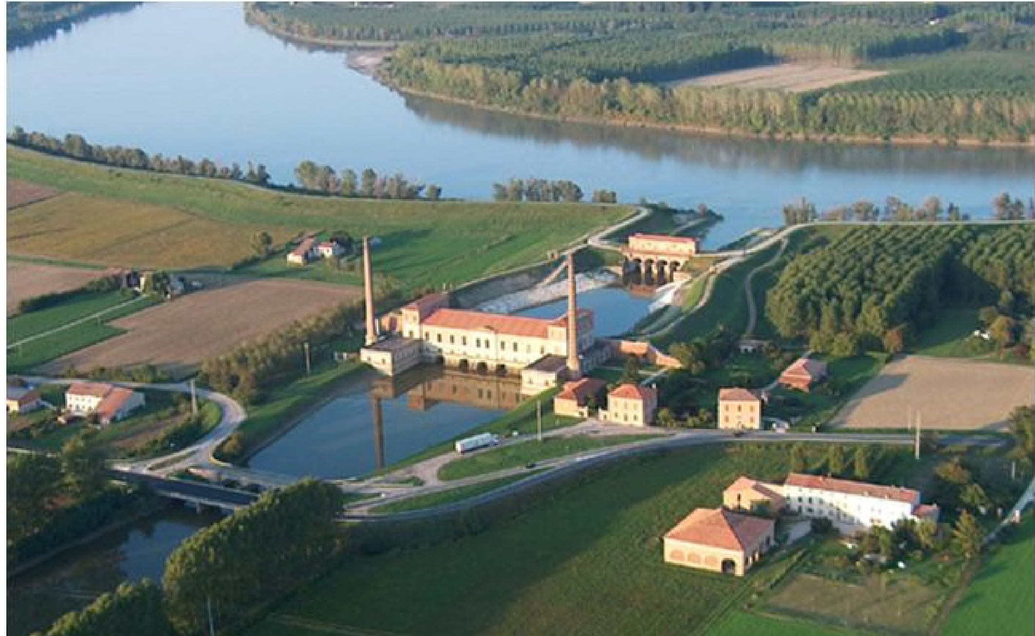
La contro-chiavica dell'impianto idrovoero della Bonifica Reggiana Mantovana di Moglia di Sermide
