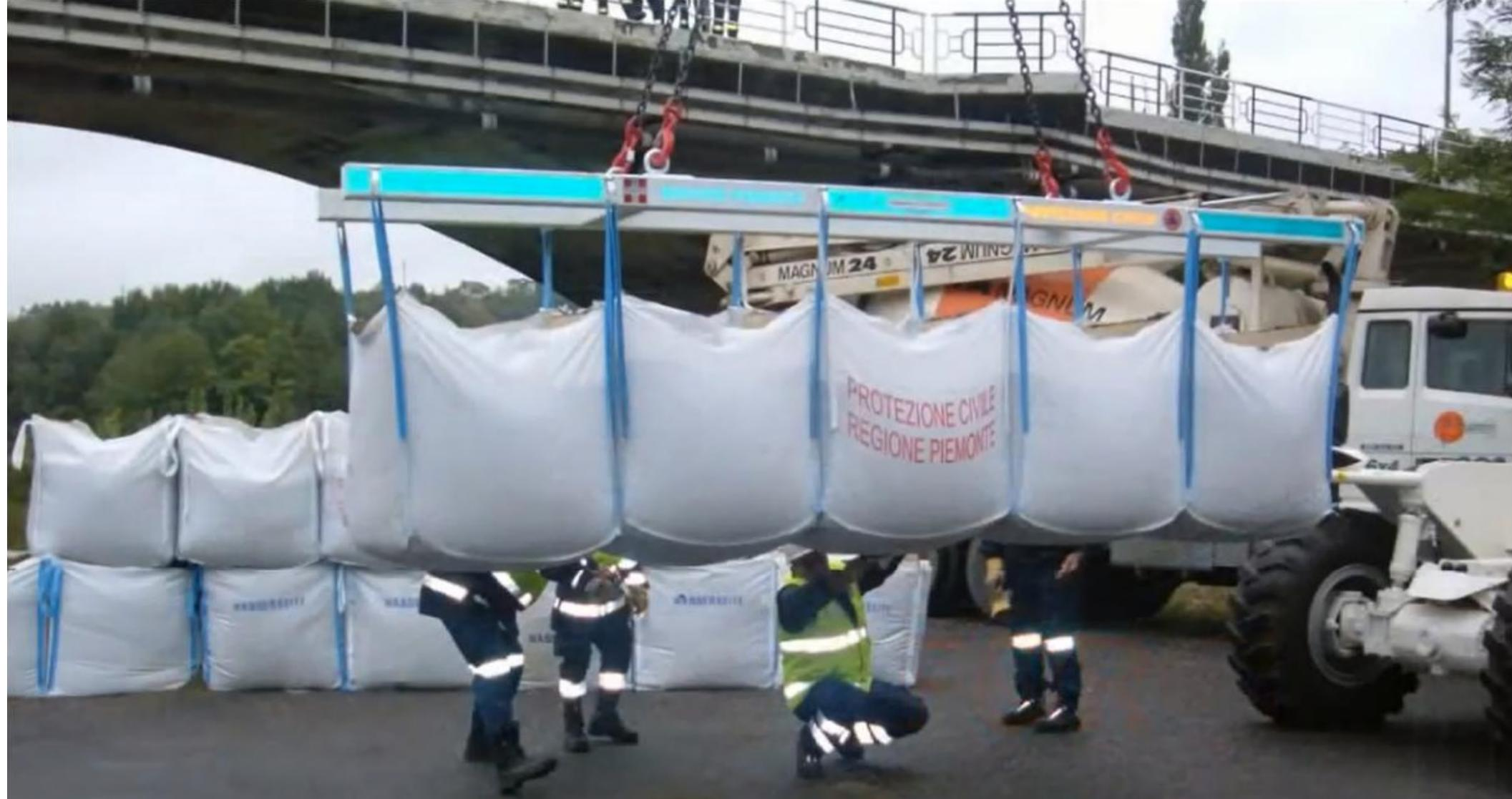
File di sacconi riempiti di sabbia possono essere utilizzati per preparare arginature in alternativa ai sacchi di sabbia. Queste barriere possono contenere fino ad un metro d'acqua e sono molto efficaci.
