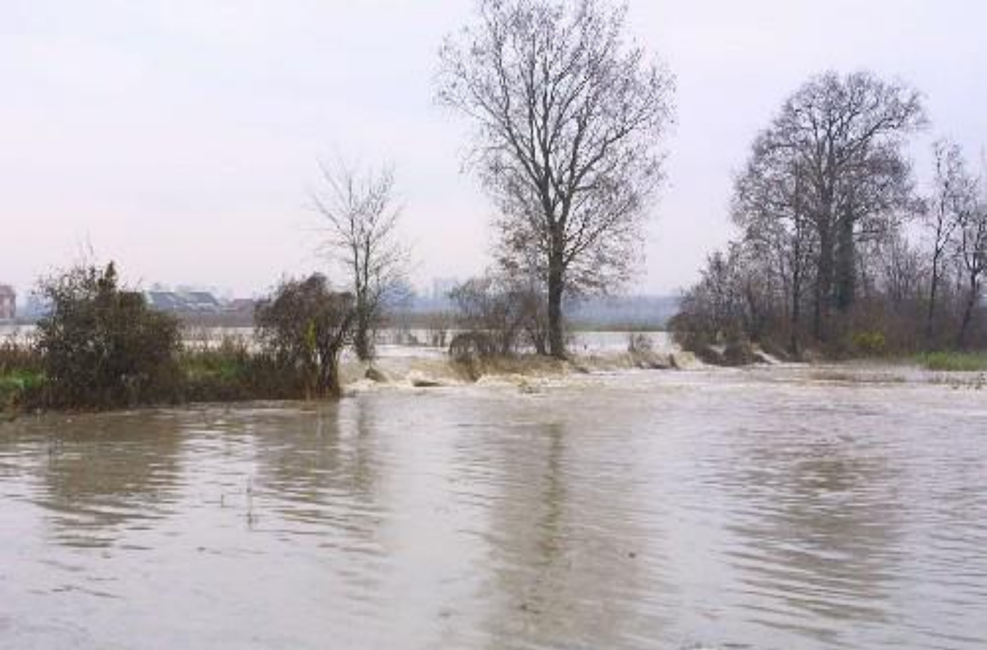
Sormonto arginale in corso Piena dell'Adda 2002 in località Bertonico
