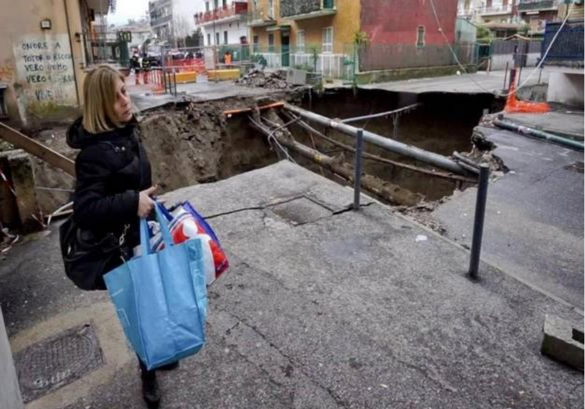
Voragine in una strada di Napoli causata dalle piogge intense
