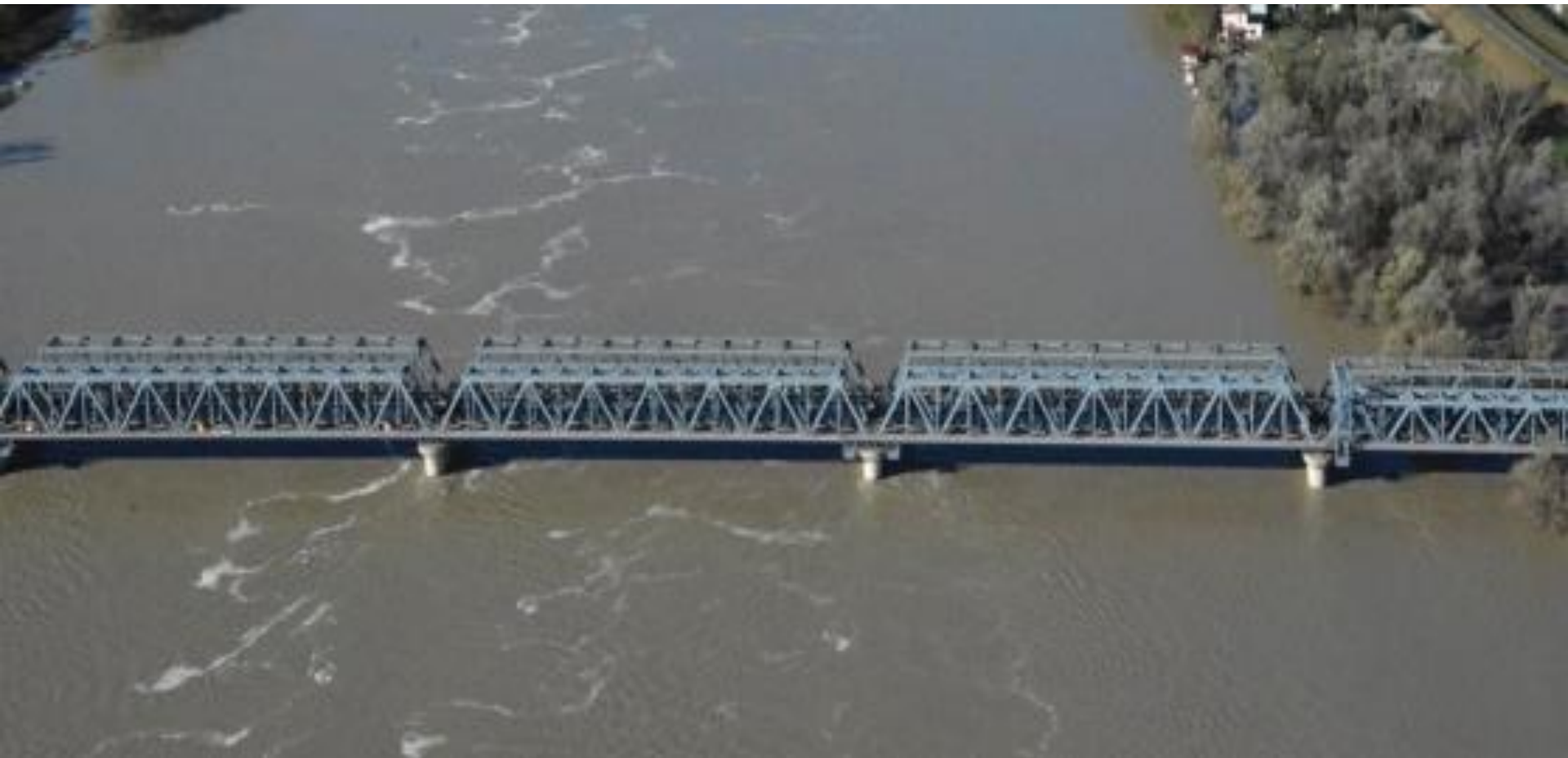
Ferrara - Innalzamento del ponte ferroviario sul fiume Po durante la piena
