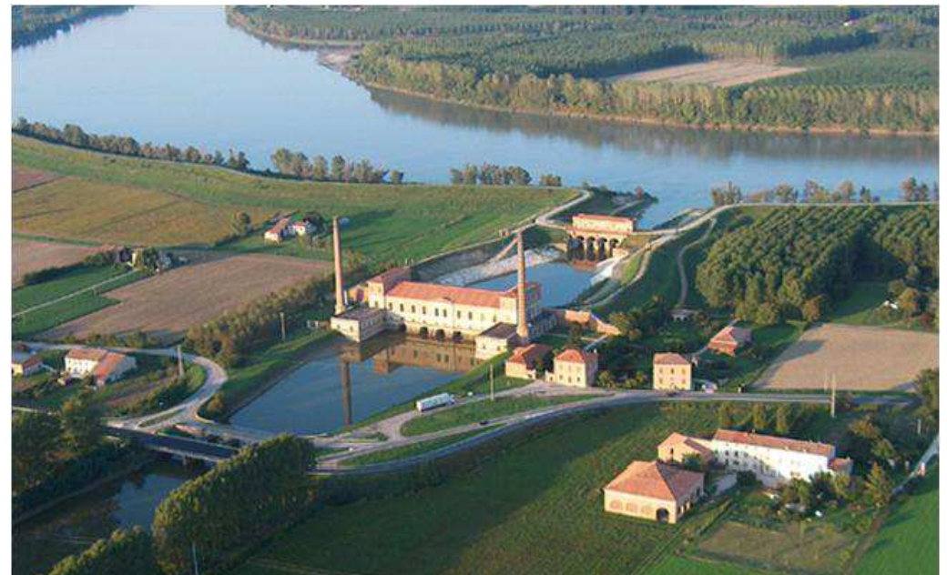
La contro-chiavica dell'impianto idrovoro della Bonifica Reggiana Mantovana di Moglia di Sermide
