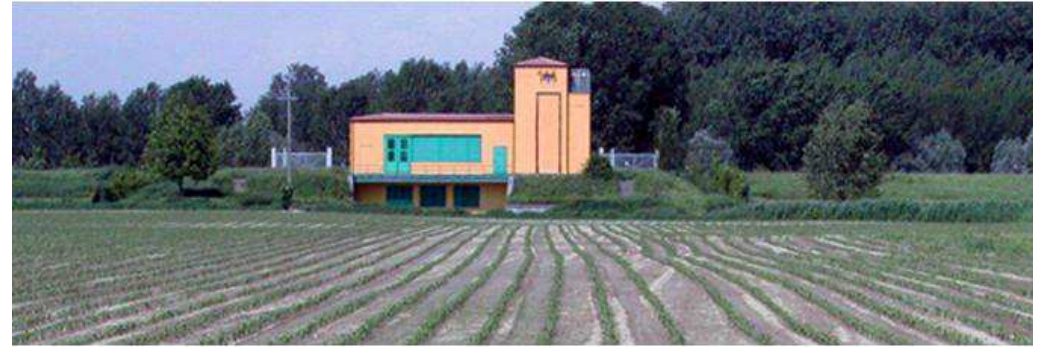
Questo è un impianto di bonifica del consorzio Muzza-Basso lodigiano. Interviene durante le piene del Po per drenare le acque di falda che affiorano e immetterle nel fiume il cui livello è di alcuni metri sopra il terreno.
