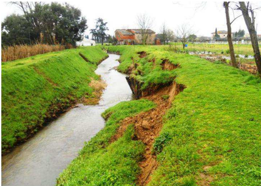
Smottamento di una riva causato dalle nutrie
