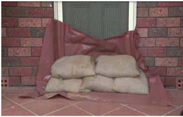
I sacchi di sabbia non sono sufficienti per prevenire l'infiltrazione dell'acqua.
