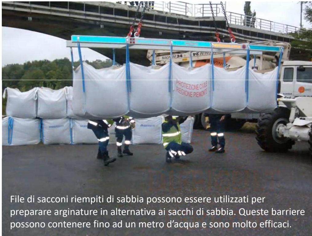
File di sacconi riempiti di sabbia possono essere utilizzati per preparare arginature in alternativa ai sacchi di sabbia. Queste barriere possono contenere fino ad un metro d'acqua e sono molto efficaci.
