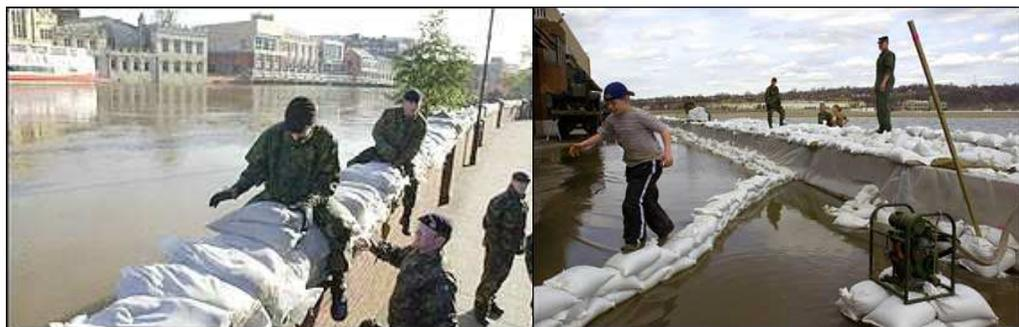
Per evitare l'allagamento delle abitazioni, l'arginatura con sacchi di sabbia è il tipo di barriera più utilizzata. Attenzione ad evitare un eventuale scivolamento in acqua camminando sui cordoli
