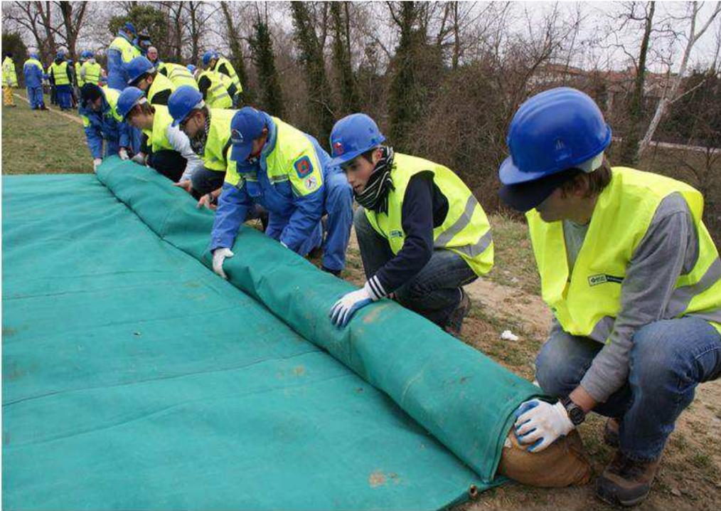
Stesura di un telo anti infiltrazione con piena in corso
