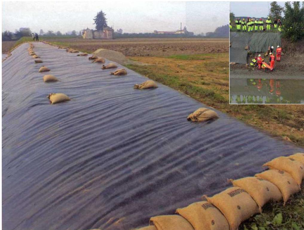
Stesura di un telo anti infiltrazione in previsione di una piena
