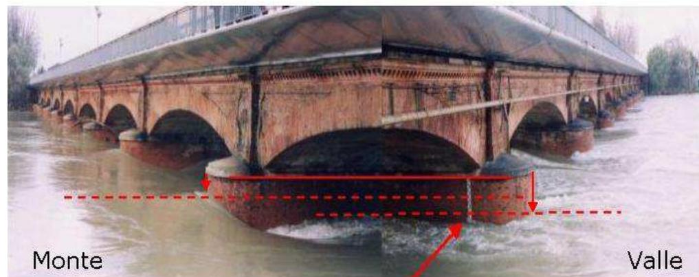
L'ostruzione del corso d'acqua generata dai pilastri del ponte provoca una differenza di livello dell'acqua tra monte e valle di circa 40 cm
