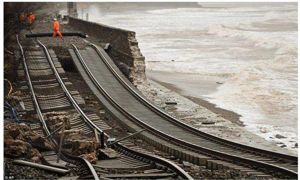
Le forti piogge e il moto ondoso hanno provocato la rottura della protezione e lo smottamento a mare del terreno sottostante la linea ferroviaria
