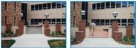
Le barriere di protezione si chiudono al sopraggiungere della piena.
