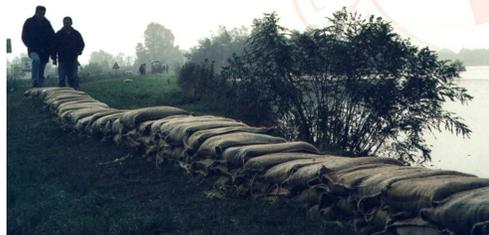
Per evitare l'allagamento delle abitazioni, l'arginatura con sacchi di sabbia è il tipo di barriera più utilizzata. Attenzione ad evitare un eventuale scivolamento in acqua camminando sui cordoli
