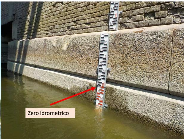
Asta idrometrica su un pilone del ponte della ferrovia a Piacenza
