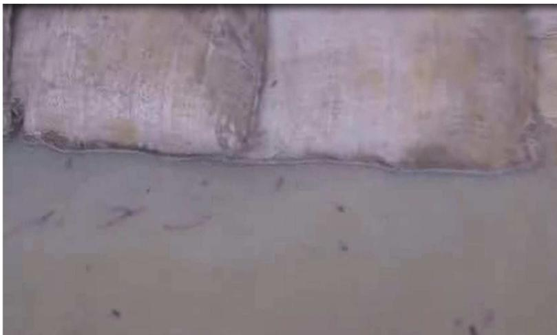
I sacchi di sabbia possono essere utilizzati per evitare che l'acqua dell'inondazione allaghi la casa. Perché l'operazione sia efficace, è necessario seguire alcune regole.
