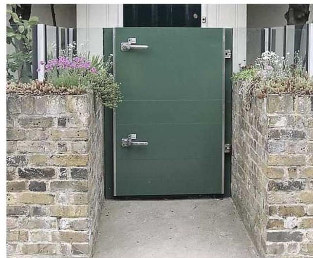
Barriera mobile in grado di contrastare esondazioni frequenti. Formata da un muro perimetrale e da una porta a tenuta stagna.
