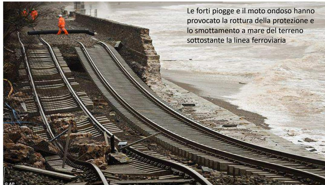
Le forti piogge e il moto ondoso hanno provocato la rottura della protezione e lo smottamento a mare del terreno sottostante la linea ferroviaria
