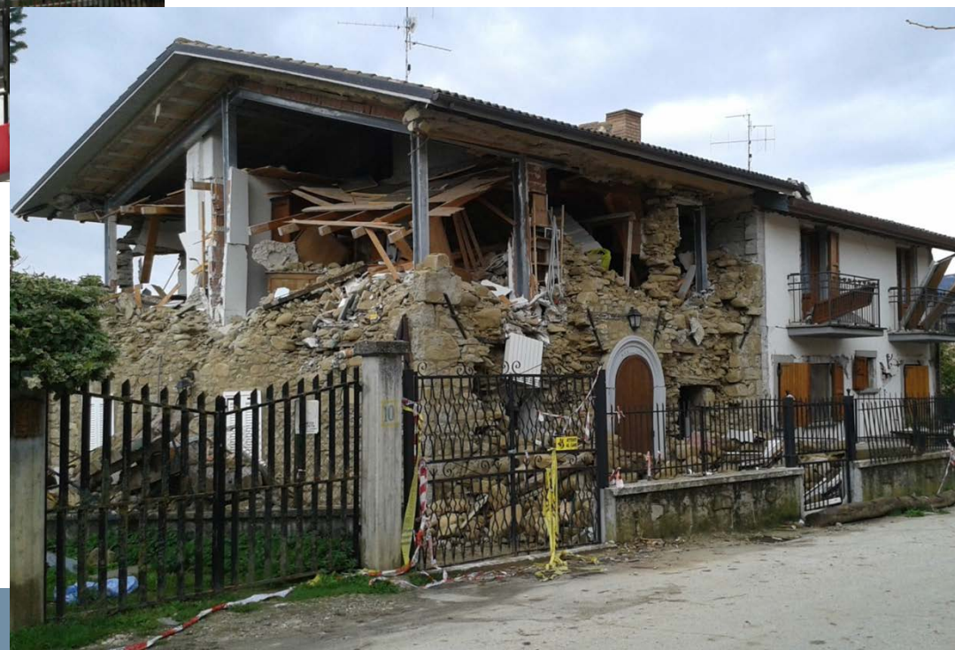
Dopo il sisma
