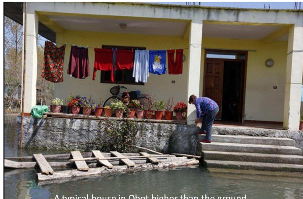
A typical house in Obot higher than the ground Nei luoghi dove le inondazioni sono ricorrenti, le abitazioni vengono costruite su rilevato
