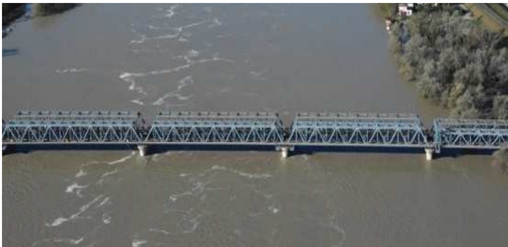
Ferrara – Ottobre 2000 – Innalzamento del ponte ferroviario sul fiume Po
