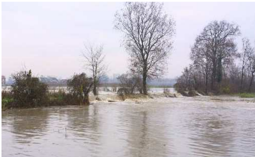
Sormonto di un'arginella su un fiume non regimato Piena dell'Adda 2002 in località Bertonico (Lodi)
