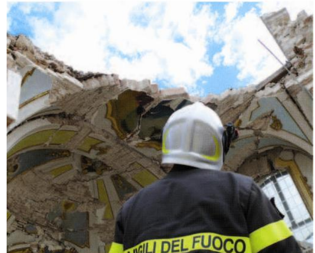
2009 Terremoto L'Aquila 309 vittime
