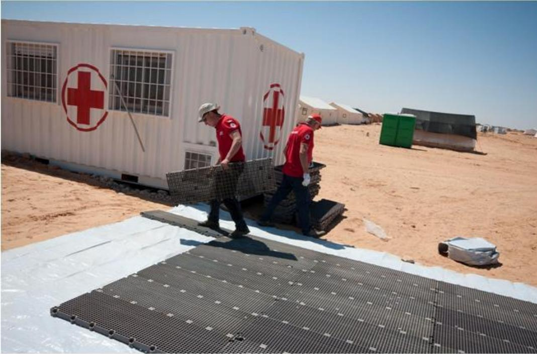
Preparazione dell'area per il montaggio dell'impianto per la produzione dell'acqua potabile. La natura del terreno, che è composto prevalentemente di gessi e argille, in caso di spandimento di acqua forma della fanghiglia difficile da gestire a causa della sua natura appiccicosa.
