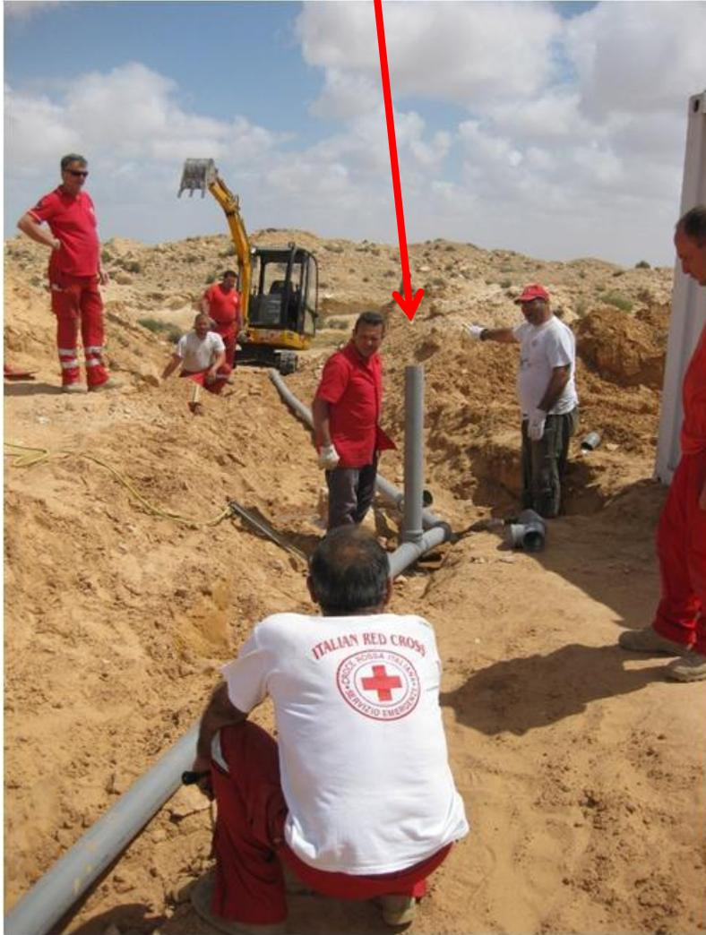
Interramento dello scarico delle acque delle cucine con tubo per l'ispezione.
