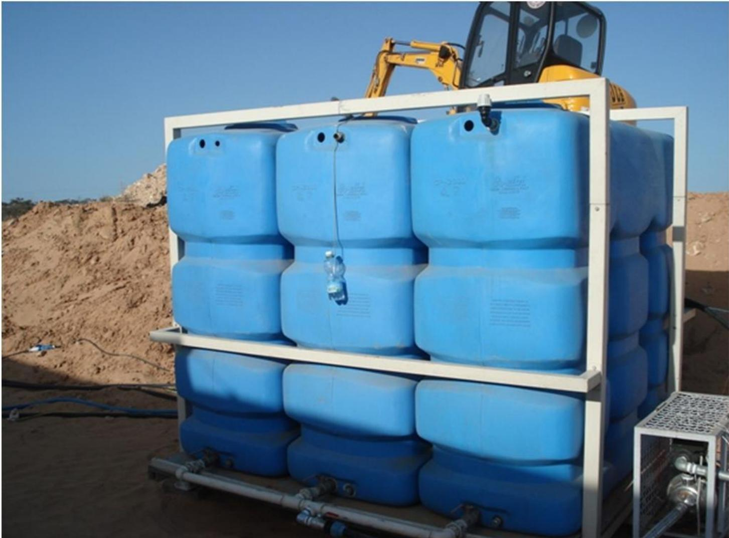
Acqua per i servizi – Acqua di scarto da osmosi inversa, quindi salmastra ma trattata con cloro per la distruzione dei batteri. Da utilizzare per bagni, lavaggio pentole, ecc.
